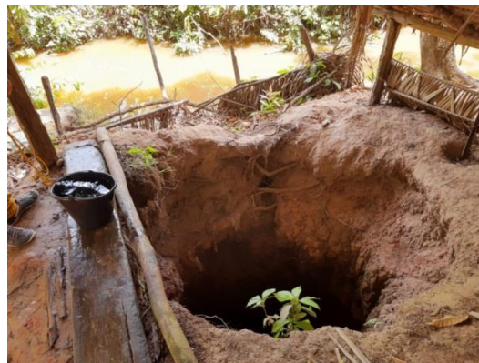
Figura 1 - Poço tipo cacimba como fonte de abastecimento em uma escola pública municipal de São João do Caru - MA
